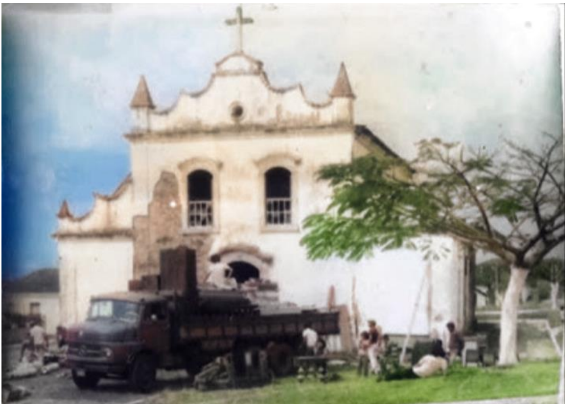
Vista da Igreja de Madre de Deus em processo de demolição. Fonte: Acervo de Itabyr Carvalho
